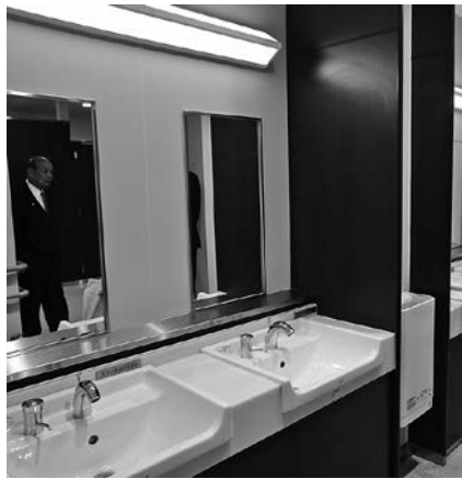
一流ホテルのような美しいトイレ
